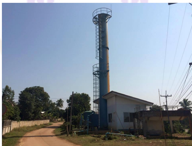
ภาพ 6 การดูแลสภาพแวดล้อมของที่ตั้งประปาทุ่งต้อม
