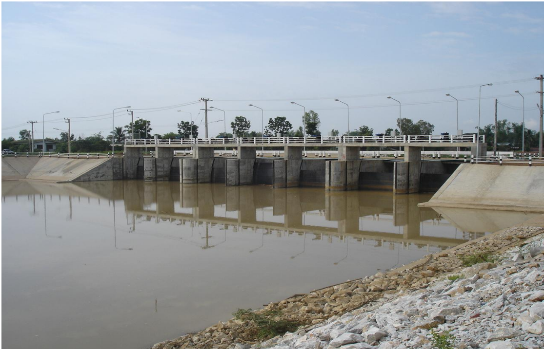
ภาพ 8 แสดงประตูระบายน้ำ
