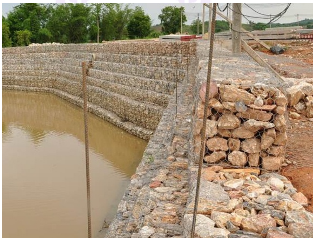
ภาพ 28 แสดงเขื่อนป้องกันตลิ่งแบบ Gabion Box บรรจุด้วยหินใหญ่คละ
