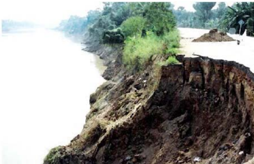
ภาพ 4 แสดงตัวอย่างการพังทลายเนื่องจากกัดเซาะของตลิ่ง
