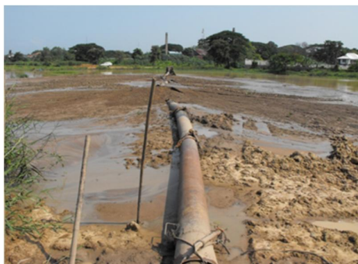
ภาพ 4 กองดินตะกอนกวี้นพะเยาที่คูดขึ้นมากองทิ้งไว้
