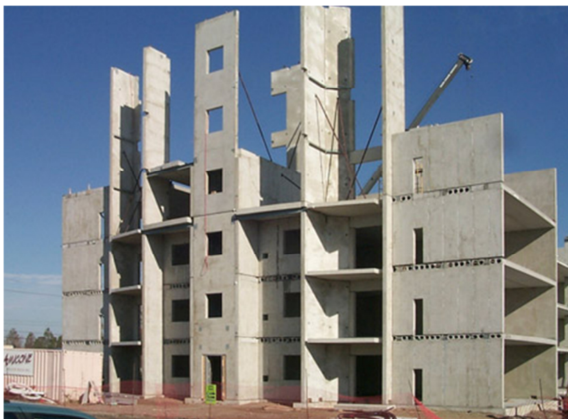
ภาพ 3 แสดงตัวอย่างอาคารระบบผนังคอนกรีตสำเร็จรูปรับแรง (Bearing wall) ในต่างประเทศ
