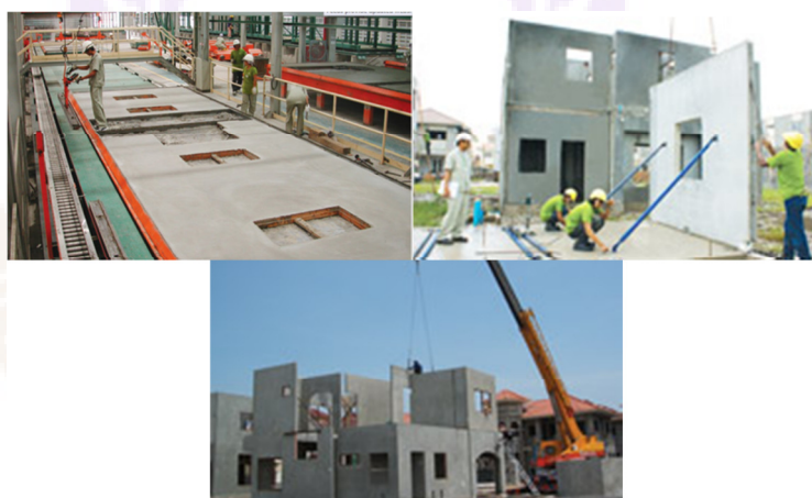
ภาพ 4 แสดงเทคโนโลยีการก่อสร้างระบบชิ้นส่วนสำเร็จรูปผนังรับแรง ของบริษัท พุกษา เร็ลเอสเตท จำกัด (มหาชน)
