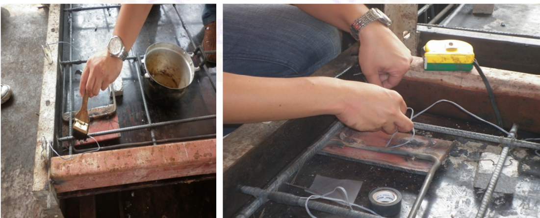
ภาพ 57 แสดงการเตรียมเหล็กเสริมในฐานผนังคอนกรีตสำเร็จรูป
