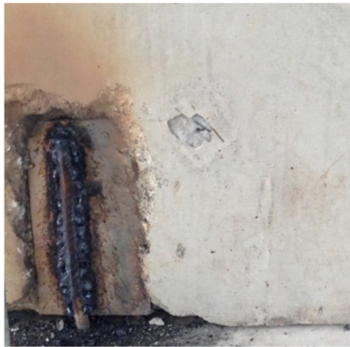
ภาพ 54 แสดงรายละเอียดจุดต่อระหว่างผนังรับแรงชั้นล่างและชั้นบน โดยใช้การเชื่อมระหว่างแผ่นเหล็กกับเหล็กเดือย
