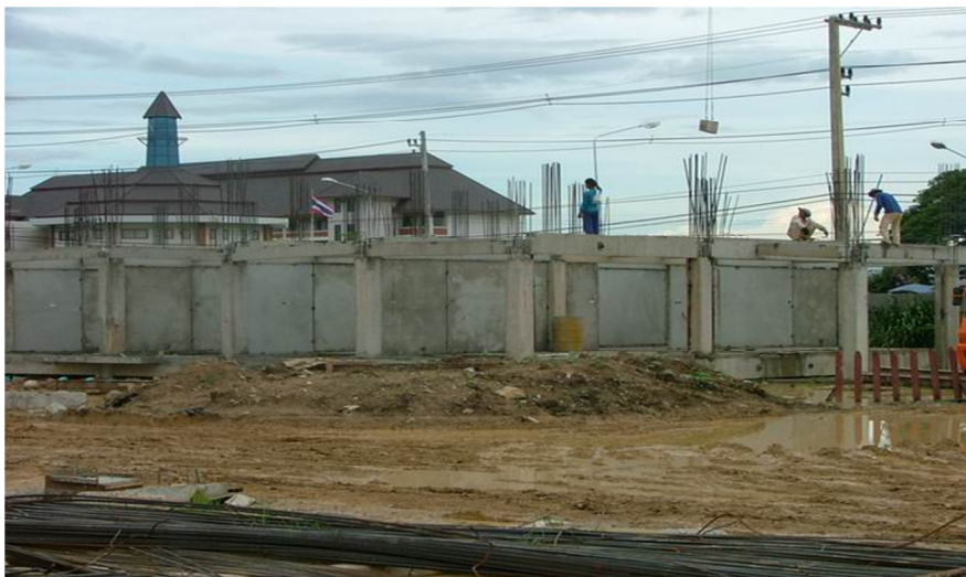
ภาพ 2 แสดงโครงการบ้านเอื้ออาทร อาคารที่พักอาศัยสูง 5 ชั้น ระบบคานสำเร็จ เสาสล่อในที่ ตำบลหนองหอย อำเภอเมือง จังหวัดเชียงใหม่
