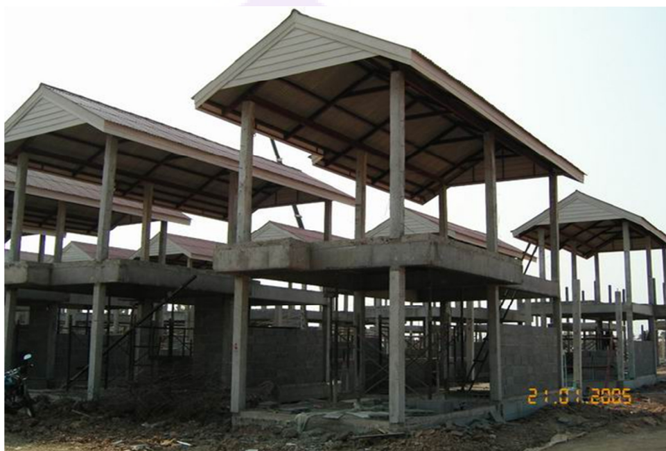
ภาพ 1 แสดงโครงการบ้านเอื้ออาทร บ้านเดี่ยว 2 ชั้นระบบคาน-เสาสำเร็จ จังหวัดสุรินทร์
