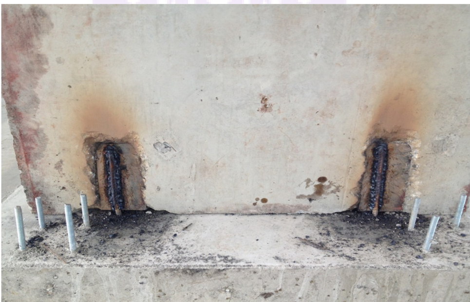
ภาพ 61 แสดงผนังคอนกรีตสำเร็จรูป (Precast Concrete Wall)
