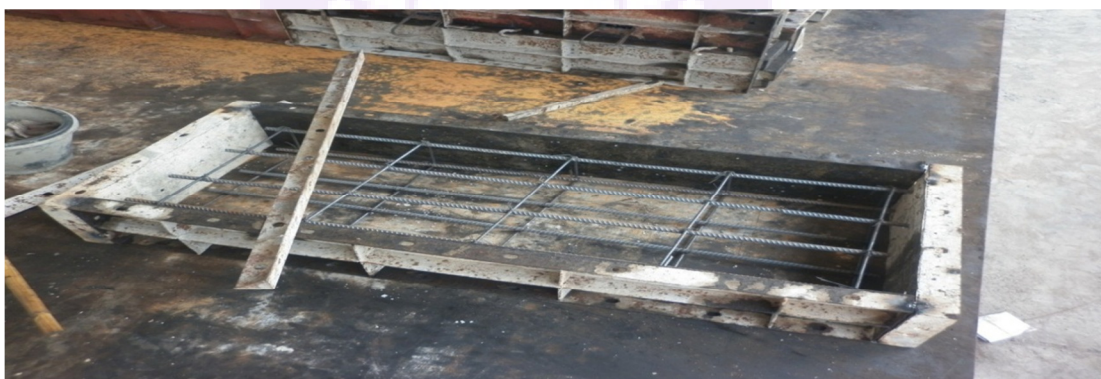
ภาพ 56 แสดงการเตรียมเหล็กเสริมในผนังคอนกรีตสำเร็จรูปและผนังคอนกรีตเสริมเหล็ก
