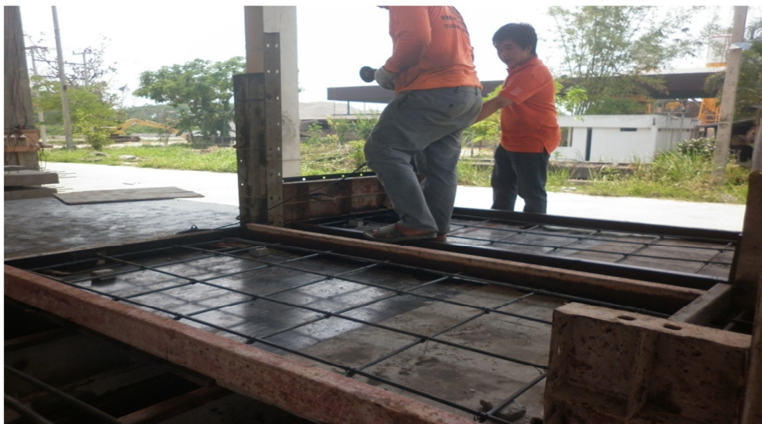
ภาพ 56 แสดงการเตรียมเหล็กเสริมในผนังคอนกรีตสำเร็จรูปและผนังคอนกรีตเสริมเหล็ก
