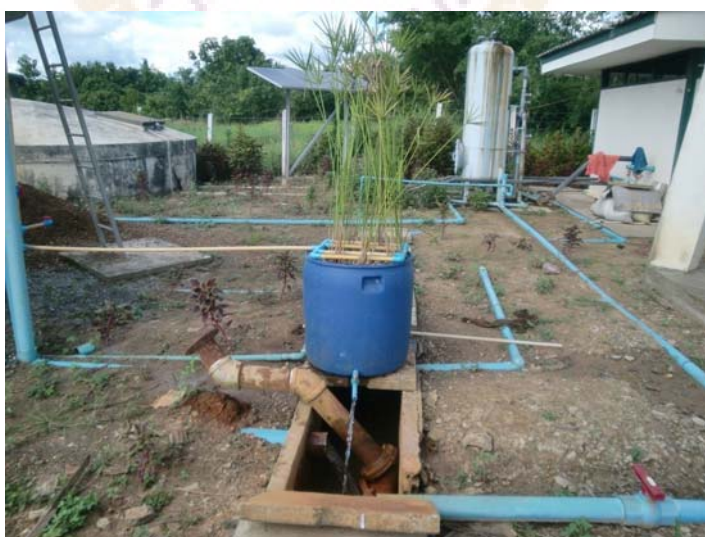
เดินระบบน้ำตามระบบประปา
