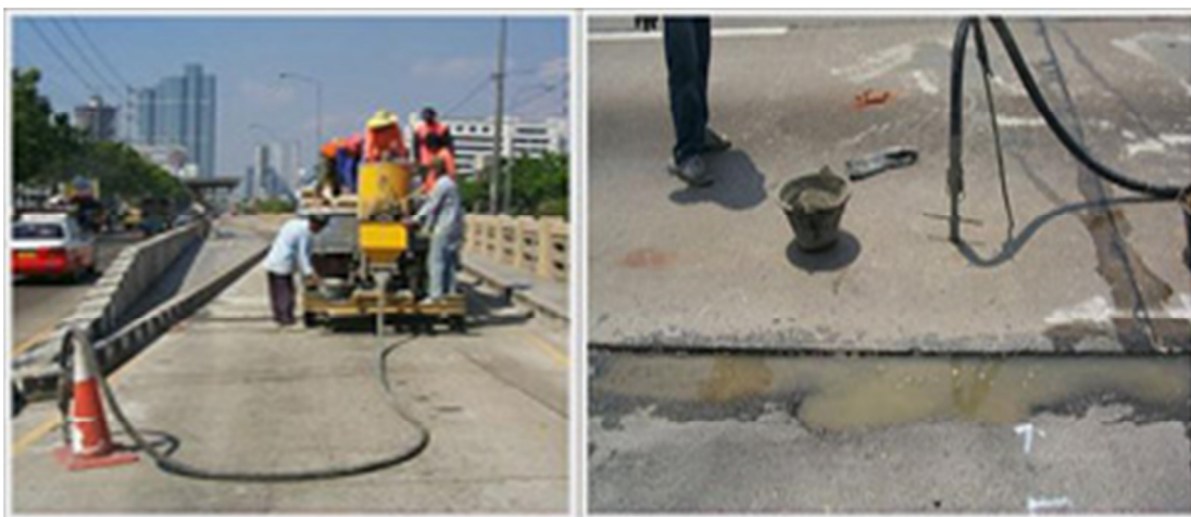
ภาพ 8 แสดงการอัดน้ำปูน (Sub Sealing)
