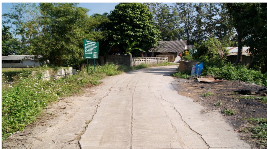
ภาพ 44 แสดงถนน คสล. ที่เสียหาย สายบ้านด้ายเจริญ-บ้านกลางเวียง ระยะทาง 4x2,000 เมตร
