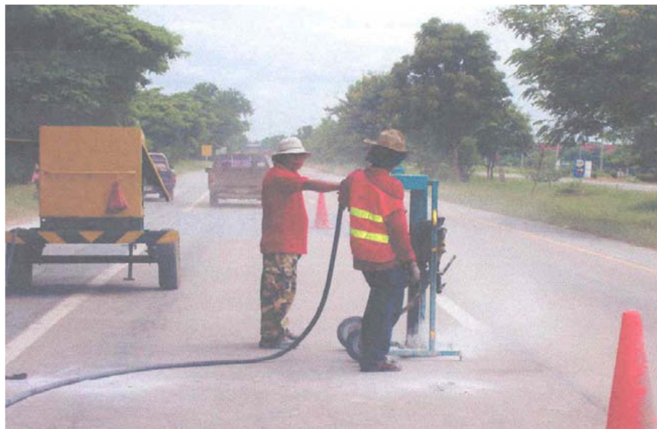
ภาพ 36 แสดงการเจาะรูแผ่นพื้นคอนกรีต
