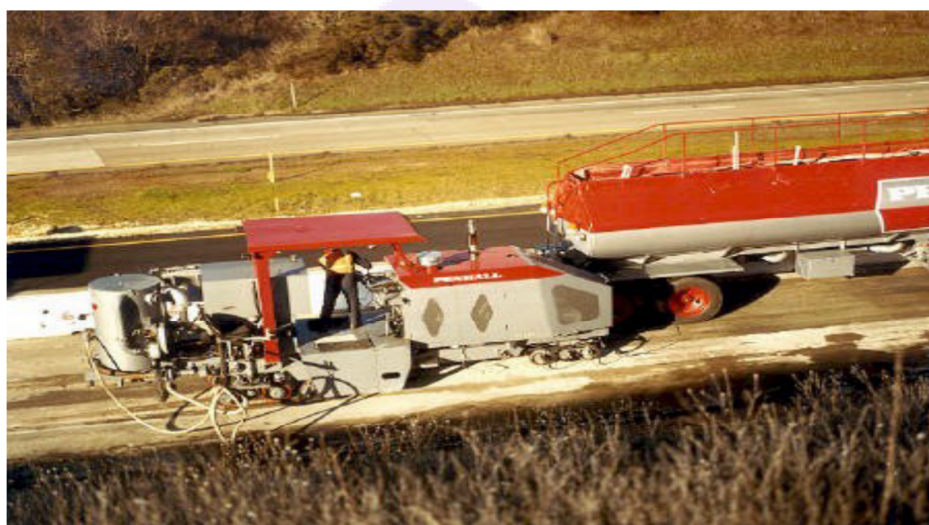
ภาพ 18 แสดงเครื่องจักร Grinding and grooving และเครื่องดูดกากคอนกรีต
