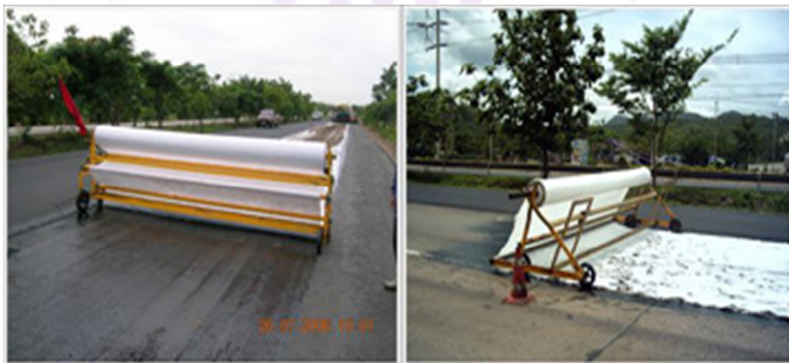
ภาพ 12 แสดงการปูแผ่นใยสังเคราะห์สำหรับงานทาง Paving Fabric
