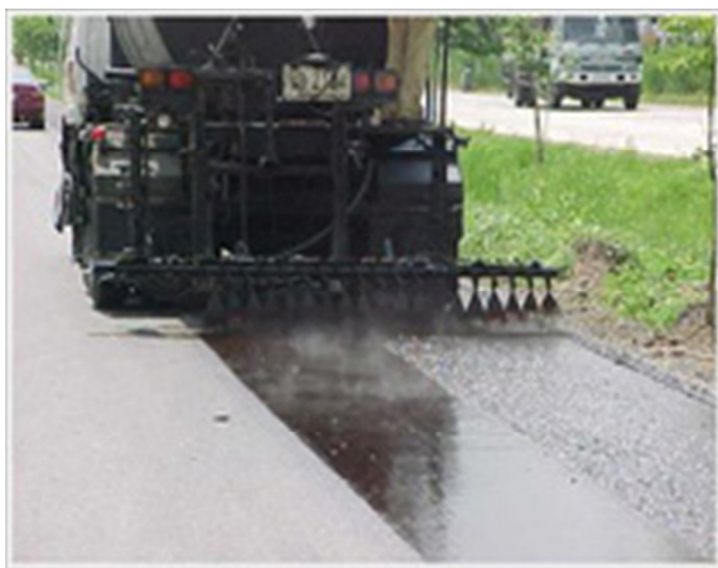
ภาพ 11 แสดงการฉีดพ่นแอสฟัลต์ TACK COAT
