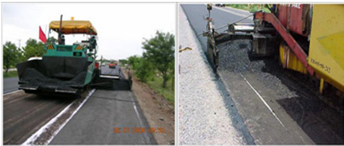
ภาพ 13 แสดงการปูผิวจราจรใหม่ (Overlay Asphalt Concrete)
