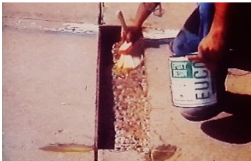
ภาพ 32 แสดงการทาน้ำยาประสานคอนกรีต
