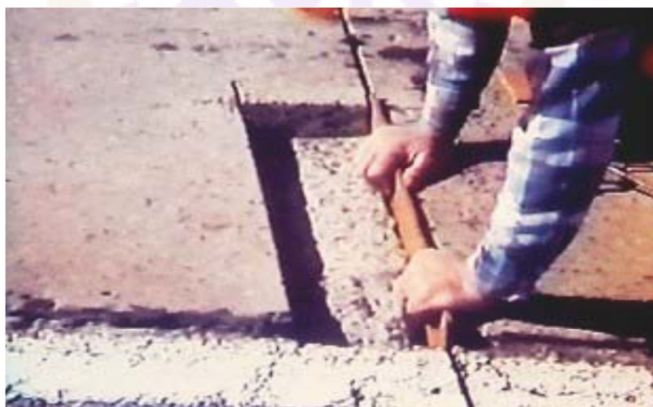
ภาพ 31 แสดงการติดตั้งแบบเพื่อเป็นฉากกั้นแนวรอยต่อผิวคอนกรีต
