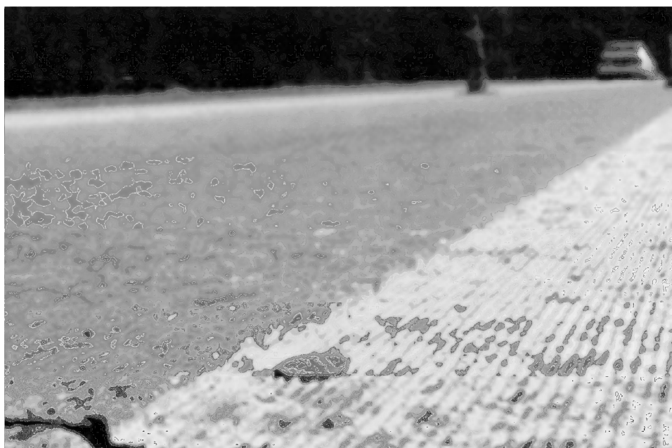
ภาพ 20 แสดงลักษณะของผิวหลังจากทำ Grinding แล้ว
