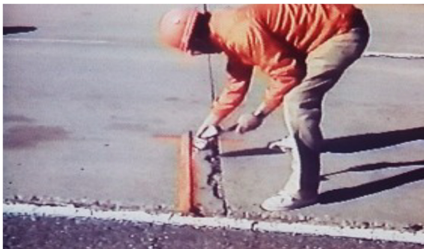
ภาพ 29 แสดงการกำหนดขอบเขตของความเสียหาย
