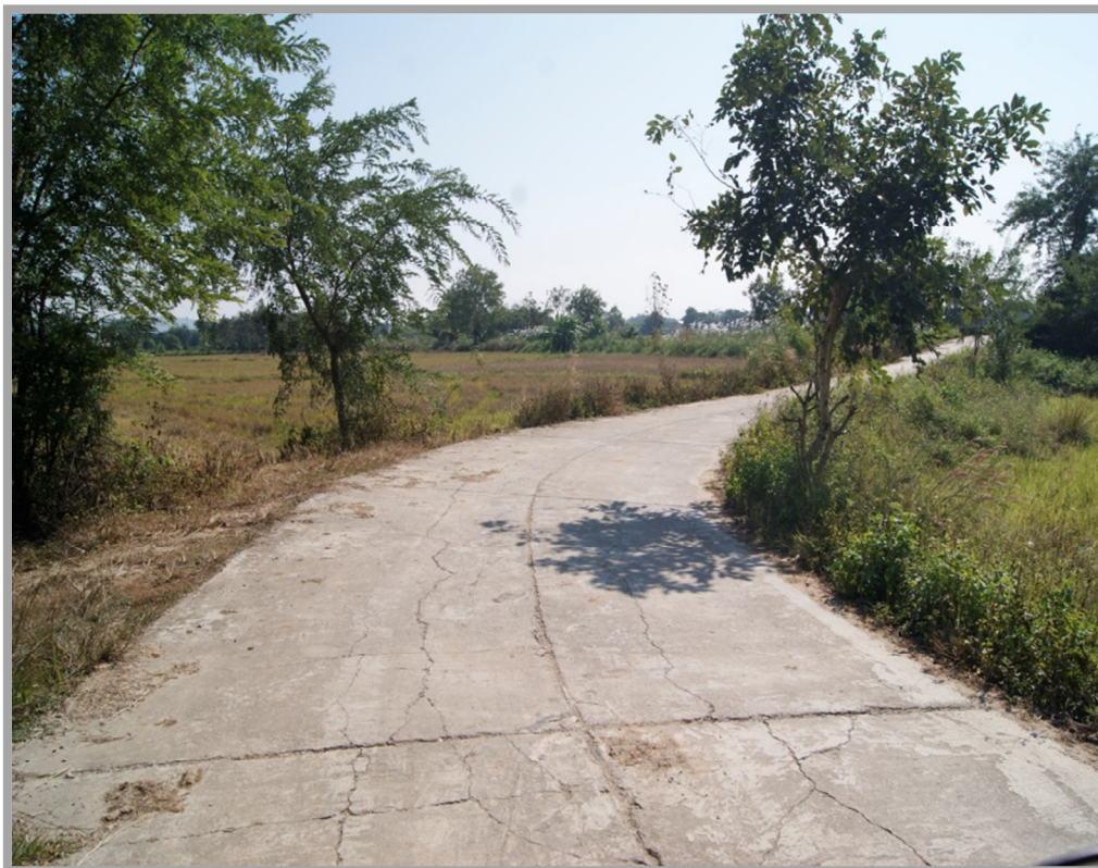
ภาพ 51 แสดงความเสียหายของ สายลำเหมืองชัยสมบัติ-บ้านท่าสาย
