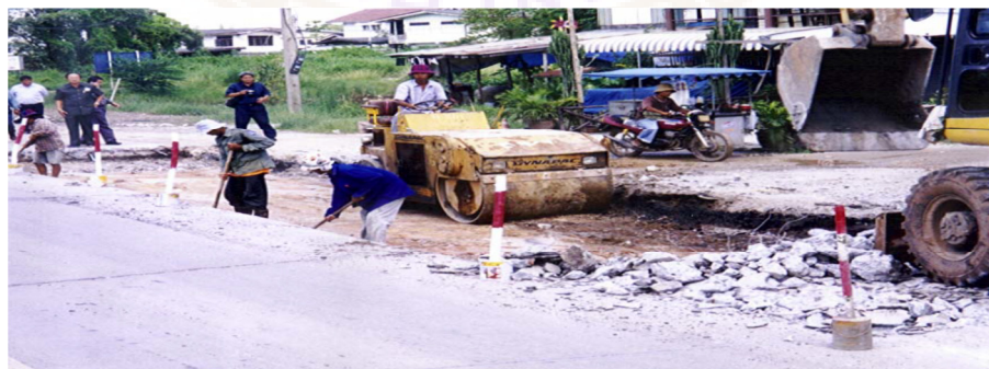
ภาพ 41 แสดงการบดอัดพื้นที่ก่อนที่จะทำการซ่อมแซม
