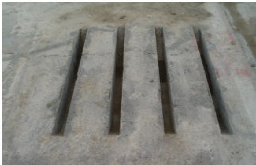
ภาพ 25 แสดงการเจาะร่องคอนกรีตตามตำแหน่งที่กำหนดพร้อมทำความสะอาด
