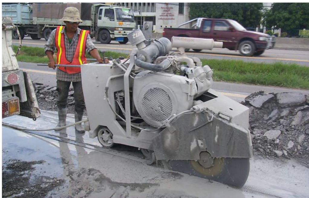
ภาพ 39 แสดงการแยกพื้นที่ที่จะทำการซ่อมแซมด้วยวิธีการใช้เลื่อยตัดคอนกรีต
