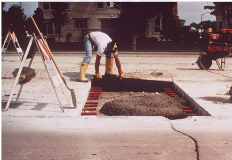
ภาพ 43 แสดงการเทคอนกรีตลงในพื้นที่ที่เตรียมไว้
