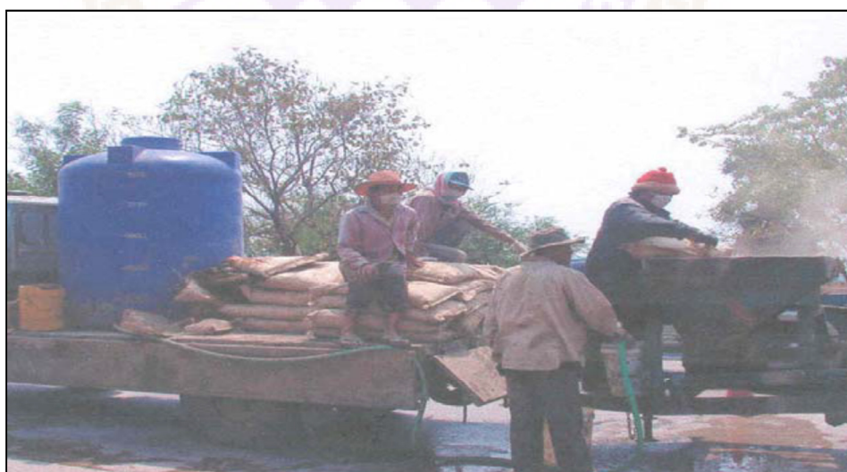
ภาพ 37 แสดงการผสมวัสดุอุดซ่อมตามสัดส่วนที่กำหนด
