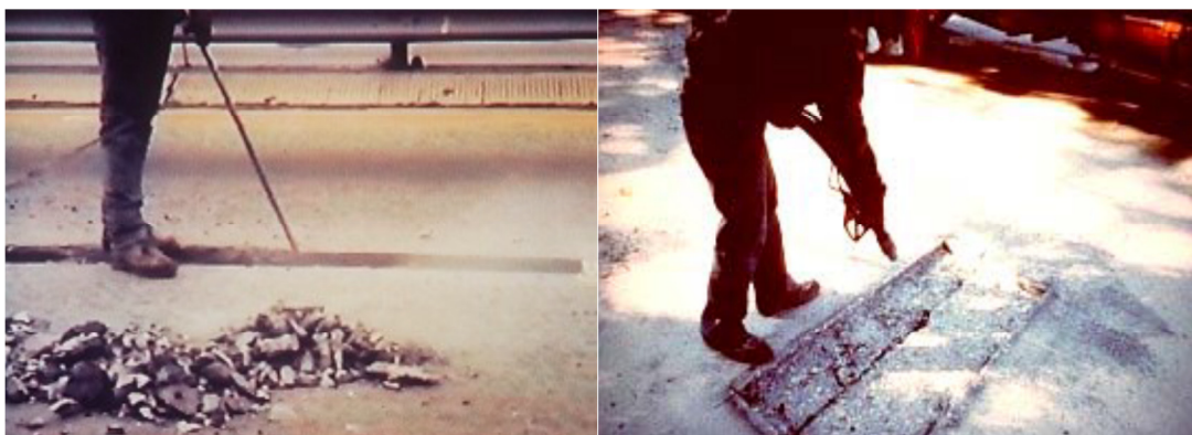
ภาพ 30 แสดงการทำความสะอาดด้วยเครื่องพ่นทราย (Sand Blast) และเครื่องเป่าลม
