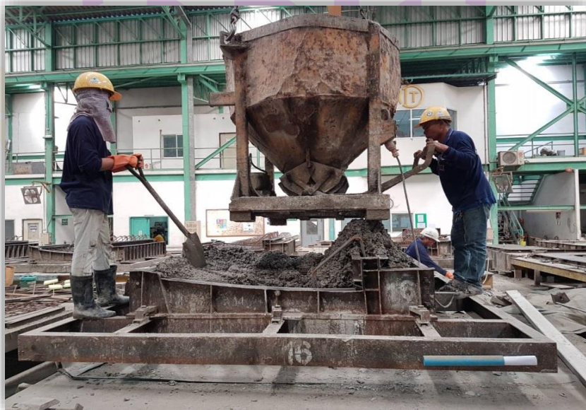
ภาพ 31 แสดงการเทคอนกรีตของชิ้นงาน
