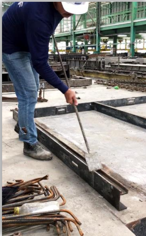
ภาพ 29 แสดงการทำความสะอาดเตรียมแบบหล่อ
