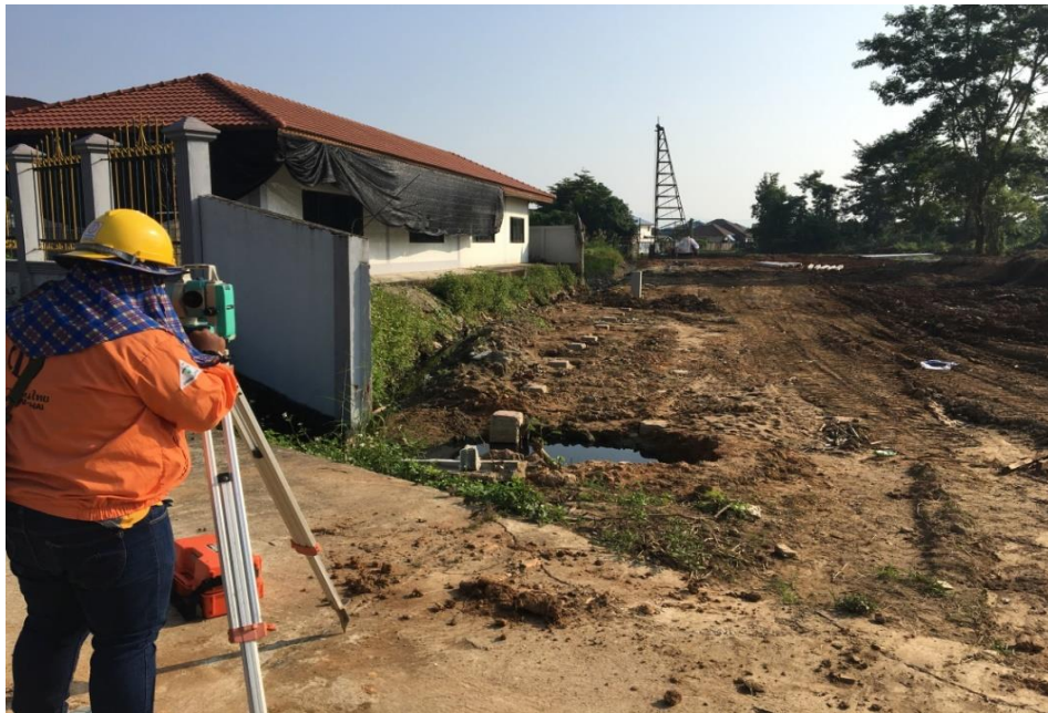
ภาพ 20 แสดงการตรวจสอบตำแหน่งระดับเสาเข็ม
