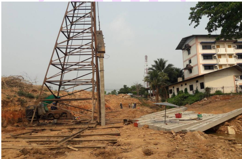
ภาพ 21 แสดงการตอกเสาเข็ม
