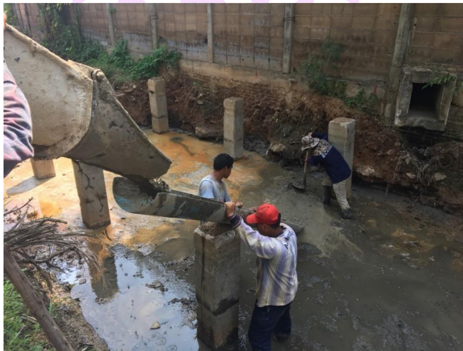
ภาพ 23 แสดงการเท Lean คอนกรีต
