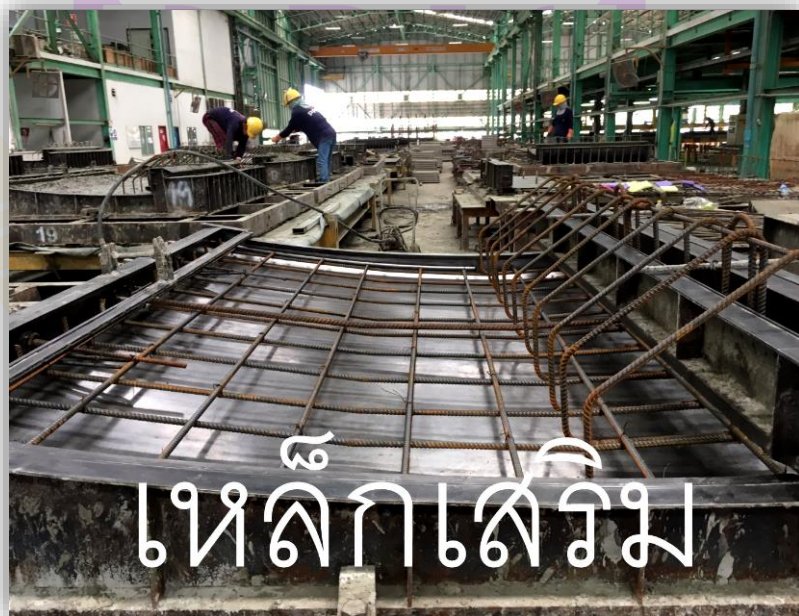
ภาพ 30 แสดงการประกอบแบบและเสริมเหล็ก
