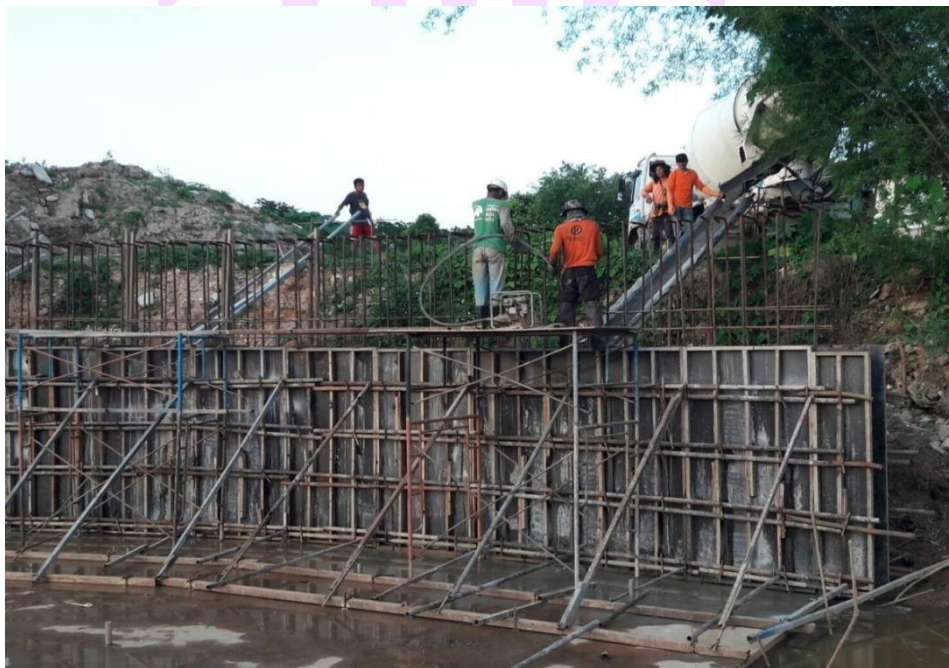
ภาพ 27 แสดงการเทคอนกรีตผนัง
